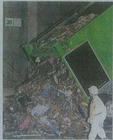
東京都大田区の破砕施設に到着した 岩手県宮古市のがれき―3日午前
